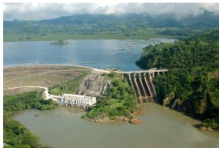
formada de materiales granulares, un vertedero de concreto de 4 compuertas y una casa de maquinas superficial.
